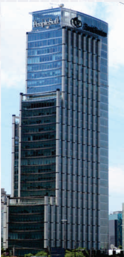
Bankboston – Reforma e implantação – Edifício New Building, incluso Presidência, Executive Dinning, Coffee Shop, andares corporativos, agência Morumbi, CPD, Hall, Saguão e cobertura – Total 5.900m²
