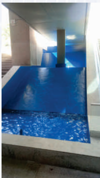
Citibank sede Paulista - Impermeabilização/reforma do espelho d'água - Av Paulista - São Paulo - SP
