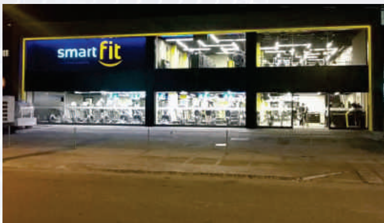
Smart Fit – Unid. Barra 6 / RJ Reforma para implantação de academia, a área de intervenção total foi de 1.623m 2
