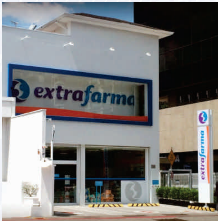
Extrafarma - Construção e implantação da unidade Faria Lima - AV. Faria Lima - São Paulo - SP
