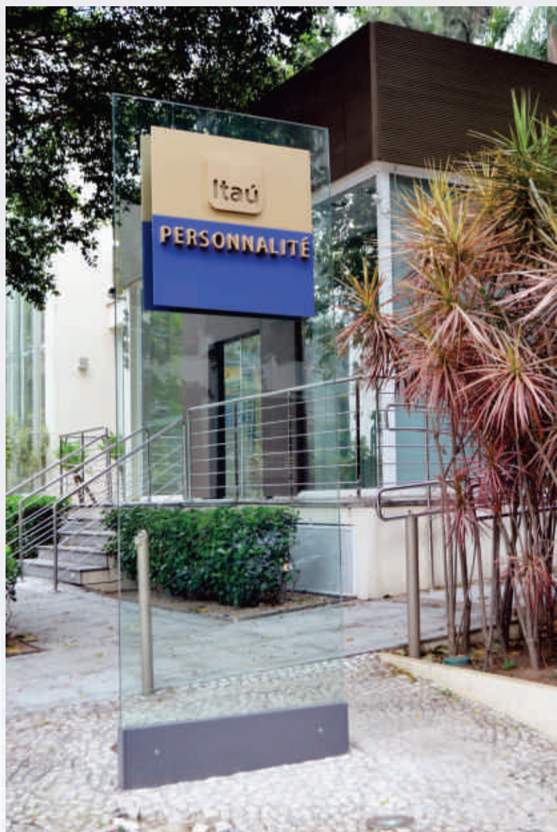
Banco Itaú Personalité - Construção e Implantação - Ag. Faria Lima - SP
