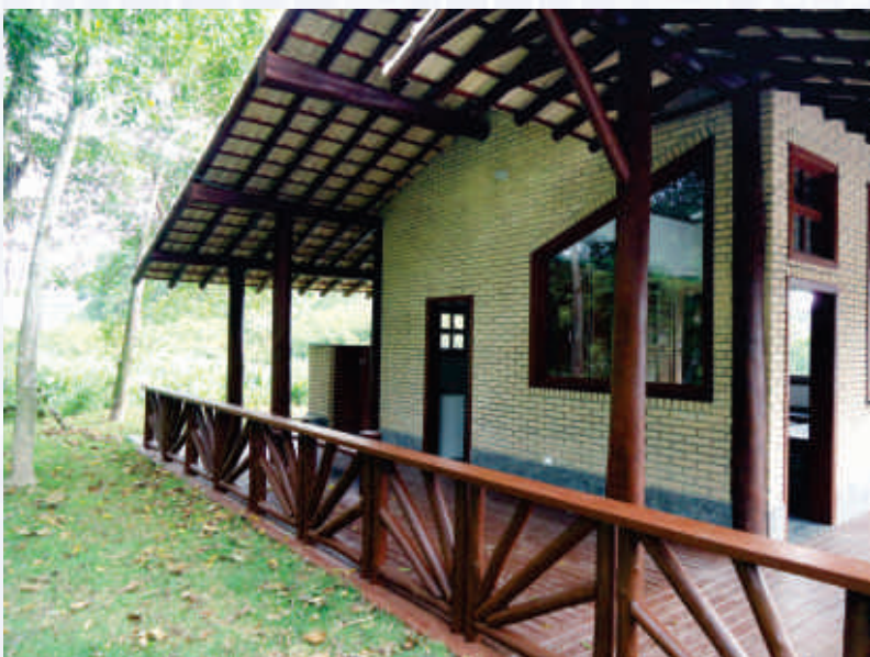
Reserva florestal Xixová - Construção e implantação Guarita e Escritório administrativo - 400 m2 - Localizado em São Vicente/SP
