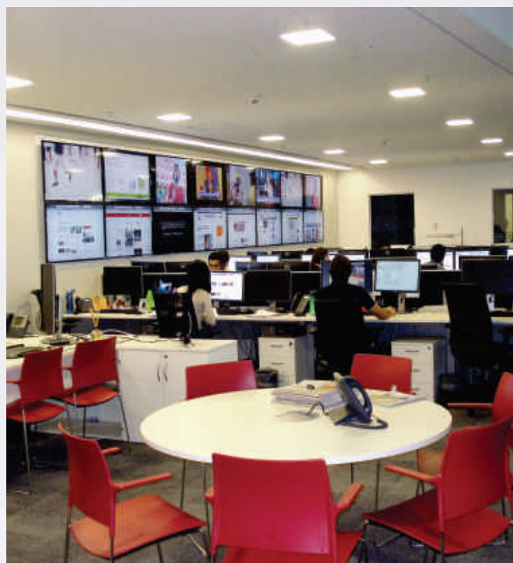
Rede Globo - Reforma completa e modernização - 1º Andar Bloco M1 Redação G1 Execução de nova infraestrutura de Ar condicionado, Elétrica, Hidráulica, CFTV, áudio e vídeo - Reforma de 3100 m2 - Localizado em São Paulo - SP
