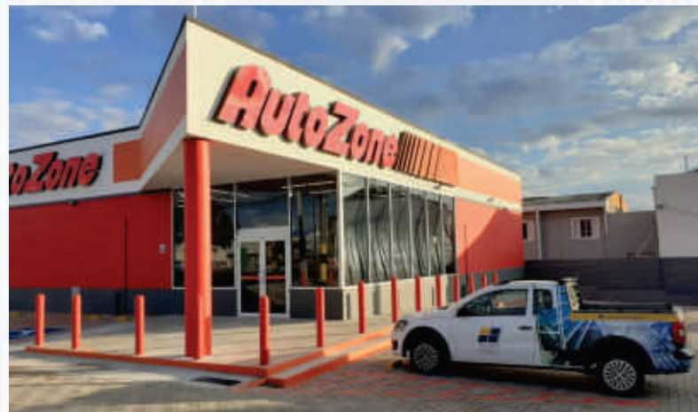
Autozone - Construção e Implantação - Mârlia - SP
