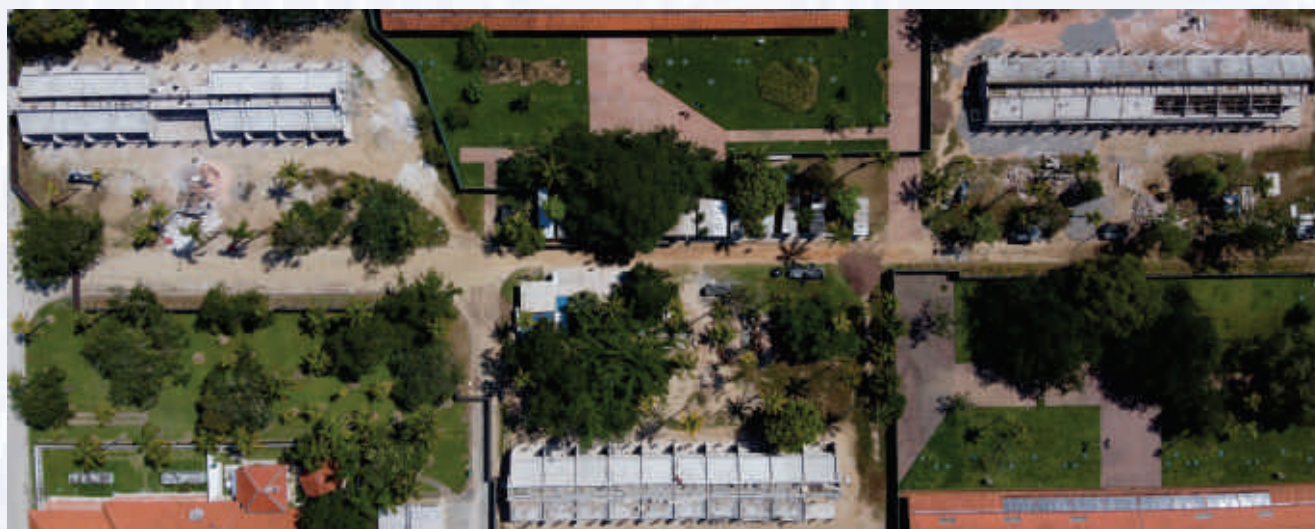
SESC Bertoga – Demolição de 3 prédios existentes e construção de novos blocos (1,3 e 8) com 3800 m2 em uma área de 7000 m2
