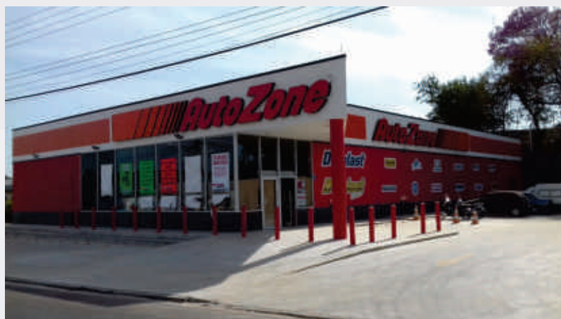
Autozone Loja Jaú - Construção e Implantação - Jaú - SP
