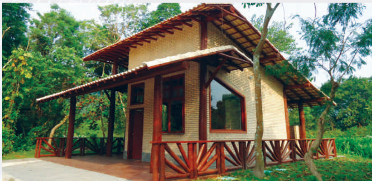
Reserva florestal Xixová – Construção e implantação – Guarita e Escritório administrativo – 400 m 2 – Localizado em São Vicente/SP
