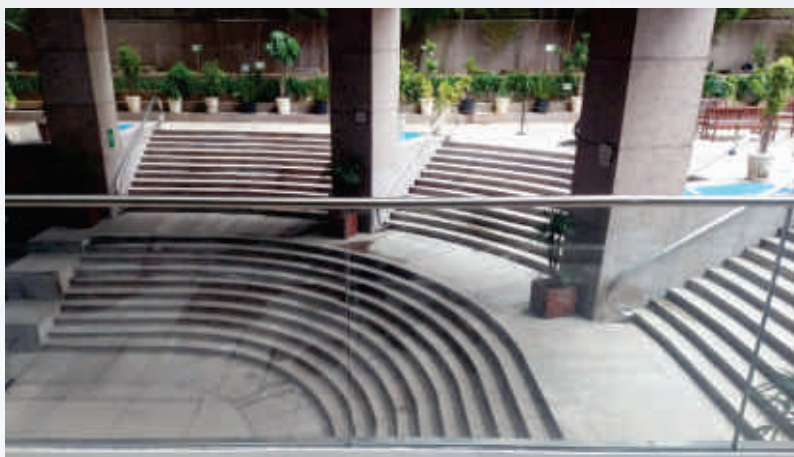
Citibank Sede Paulista – Impermeabilização total do térreo (5000m2) com substituição parcial do piso elevado de granito, incluindo troca das escadas rolantes, impermeabilização do espelho d'água e execução de guarda corpo em inox e vidro na passarela.
