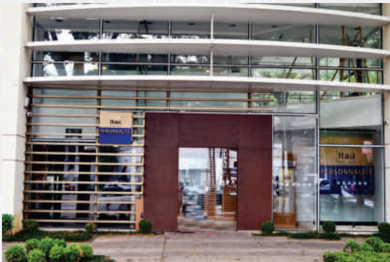
Banco Itaú Personalité - Construção - Ag. Estados Unidos com hadock Lobo - SP
