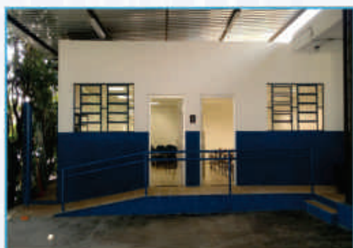
Projeto Nossa Turma - Reforma completa das salas de aula, ampliação da creche e construção de nova sala de aula e almoxarifado. Além, da doação de materiais executamos os serviços sem custos a instituição - Portão 7 - CEAGESP - SP
