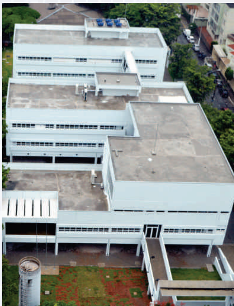
Batalhão da Polícia Ambiental - Construção 1ª fase - Casa Verde Alta - SP Acerto do terreno, implantação da área de vivência e canteiro, escavações, fundações, estrutura pré-moldada, escadas e lajes, fechamentos em alvenaria, contrapisos, entrada de energia, cabine primária, entrada de água, reservatório subterrâneo e reservatório elevado.
