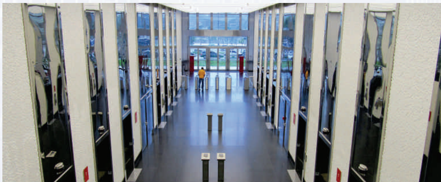
Torre Santander - Modernização elevadores, controle de acesso, troca de iluminação e revitalização de piso e paredes - SP
