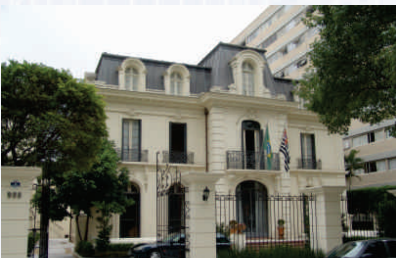
ABIT - Restauração Sede Social - Patrimônio Tombado - Rua Marques de Itu - SP
