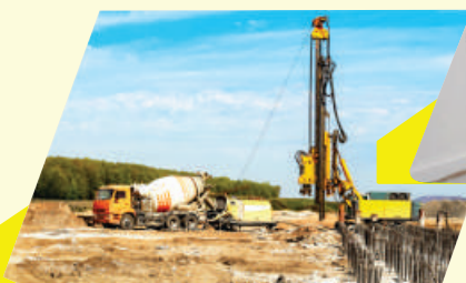
Perfurações e sondagens
