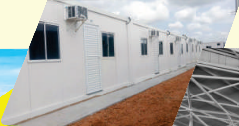
Alojamentos em módulos termo acústicos
